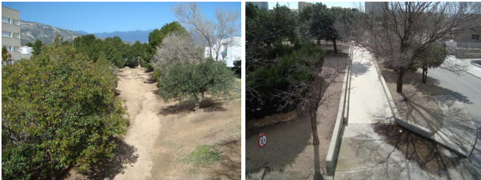
Figura 39. Torrent a la zona del sector Hifrensa
